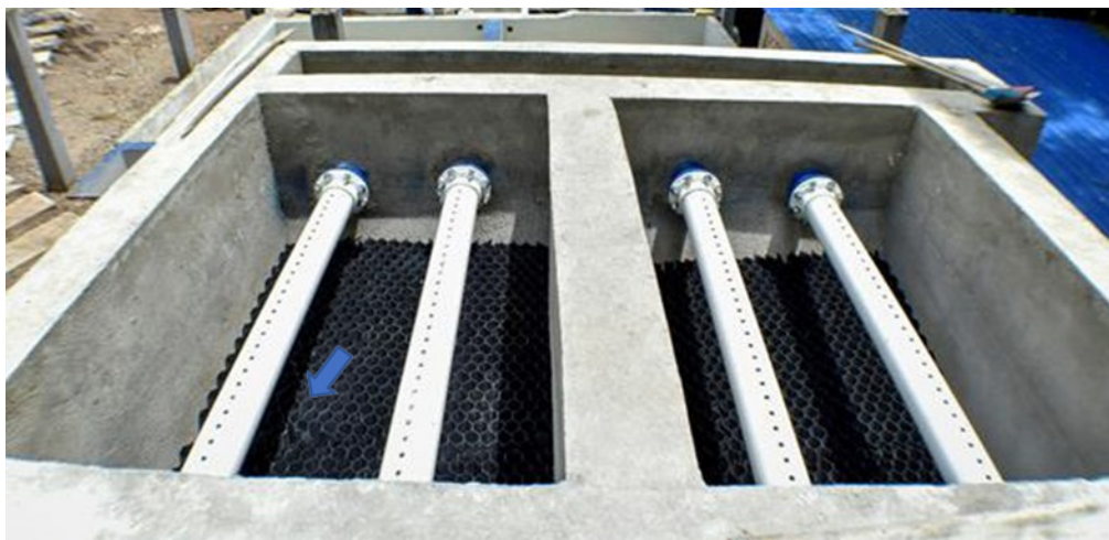
Figura 10. Sedimentador Laminar
