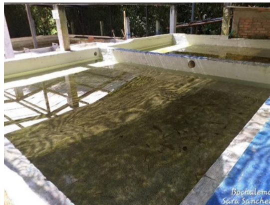
Figura 11. Filtro Rápido de Flujo Ascendente
