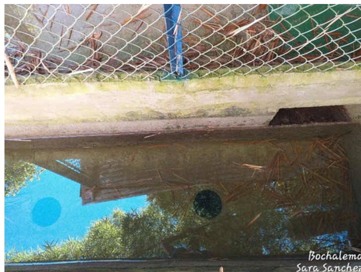
Figura 14. Unidad de Desinfección
