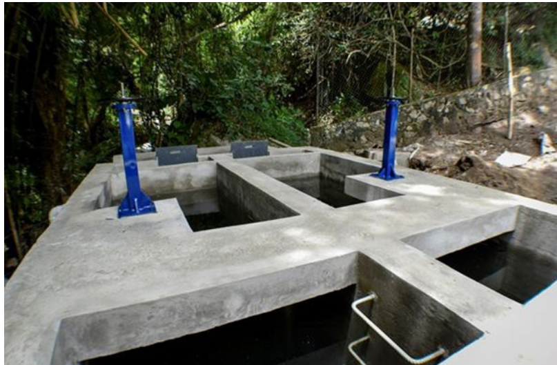
Figura 5. Estructura del Desarenador
