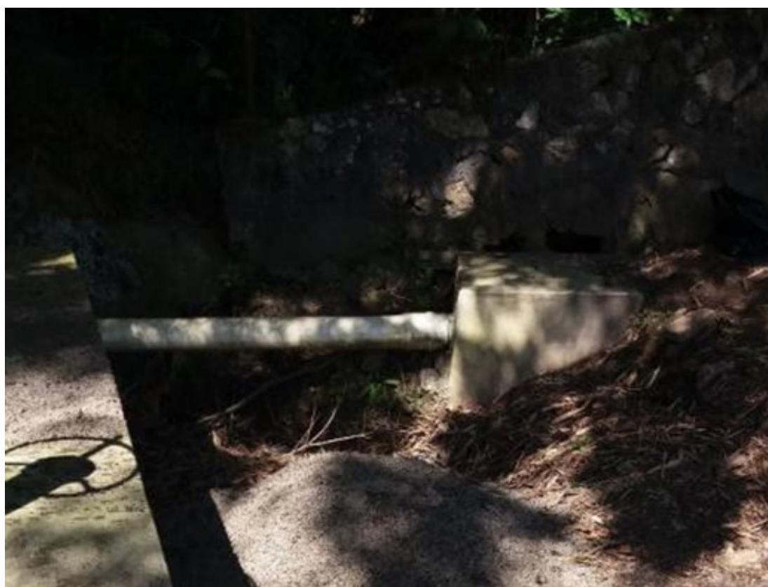
Figura 4. Canal de Ingreso al Desarenador
