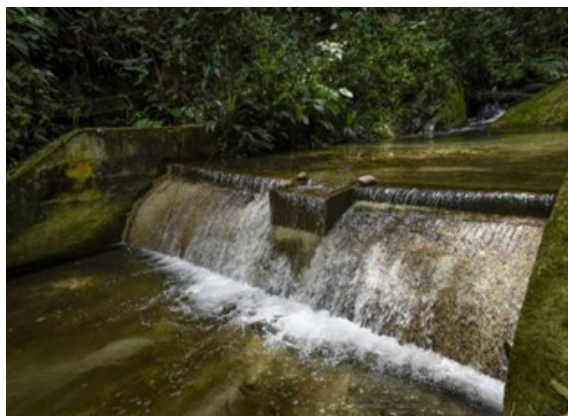
Figura 2. Estructura de Captación Quebrada Aguablanca Planta el Topacio
