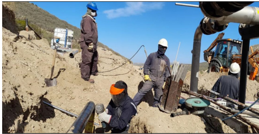
Figura 5. Operario se encuentra cepillando cañería de 4 con amoladora angular 750/115 mm
