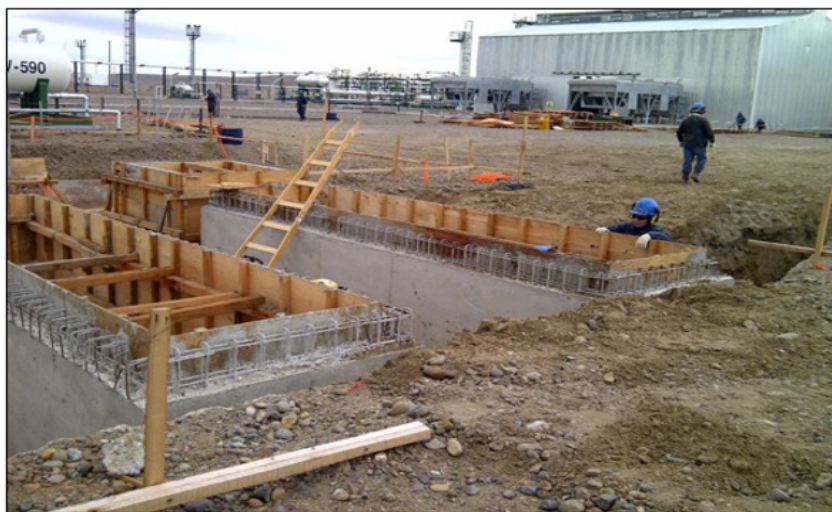
Figura 9. Encofrado de cámaras
