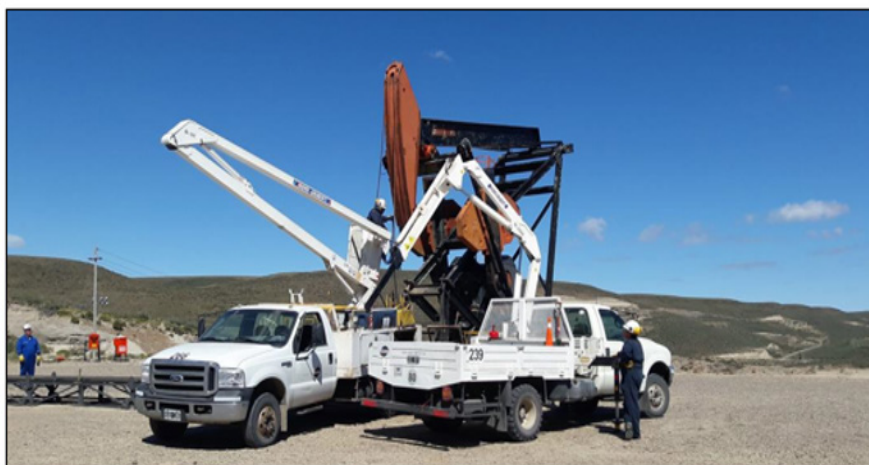
Figura 10. Dos cuadrillas en conjunto realizando cambio de estrobo en cabeza de mula
