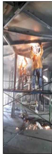
Figura 6. 4-5 Soldadura en espacio confinado con andamio en tanque cortador, planta sur
